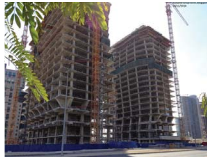
The Opus: construction site 2015
